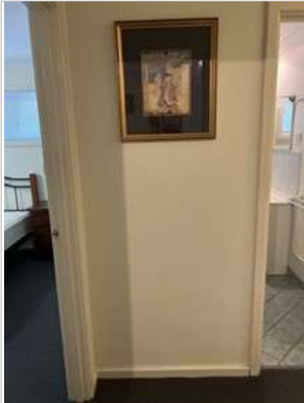
Hallway 02/05/2023 2:34 PM Image 99 :Walls
