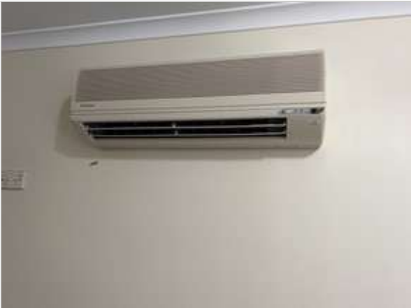
Bedroom 2 02/05/2023 2:15 PM Image 245 :Walls
