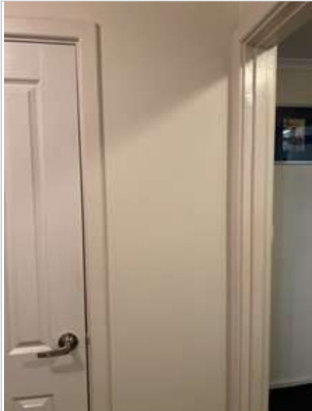
Laundry 02/05/2023 2:01 PM Image 387 :Walls/ Tiles
