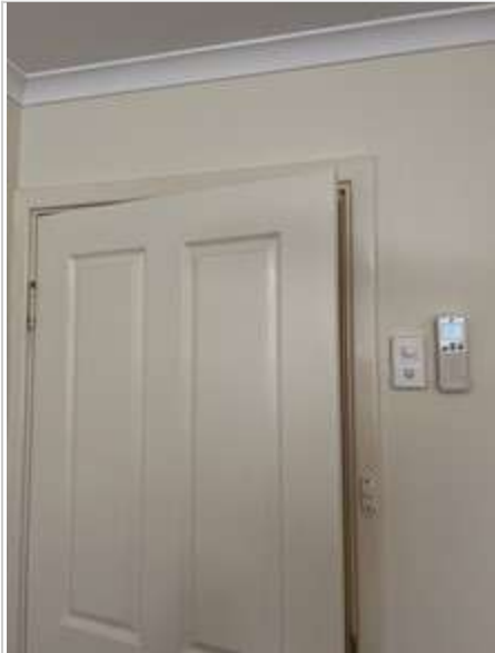
Bedroom 2 02/05/2023 2:12 PM Image 240 :Walls
