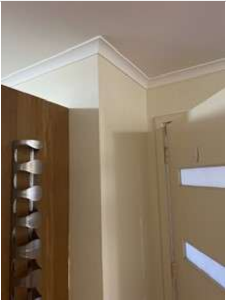
Dining Room 02/05/2023 3:42 PM Image 336 :Walls
