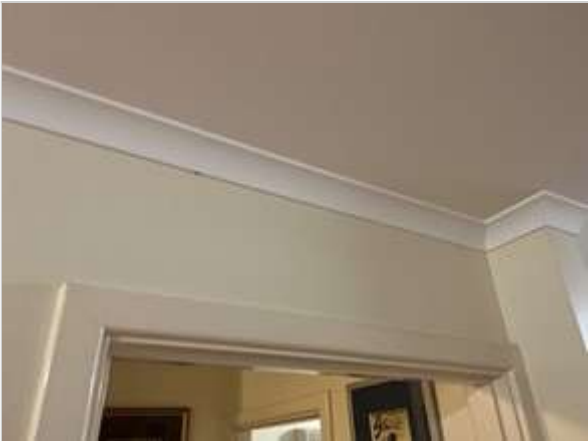
Dining Room 02/05/2023 3:42 PM Image 333 :Walls
