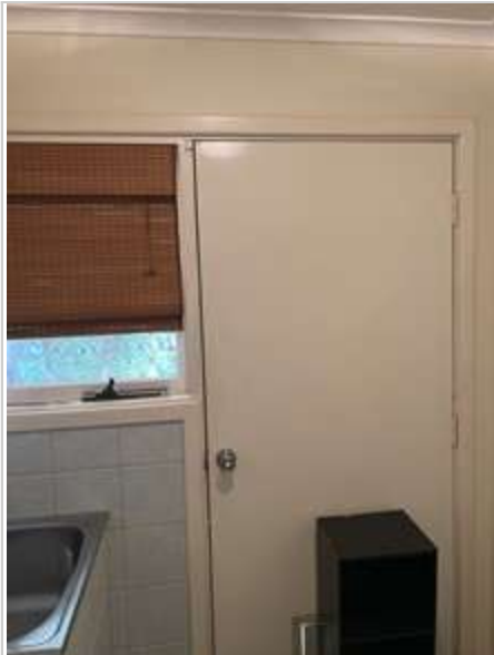
Laundry 02/05/2023 2:01 PM Image 389 :Walls/ Tiles
