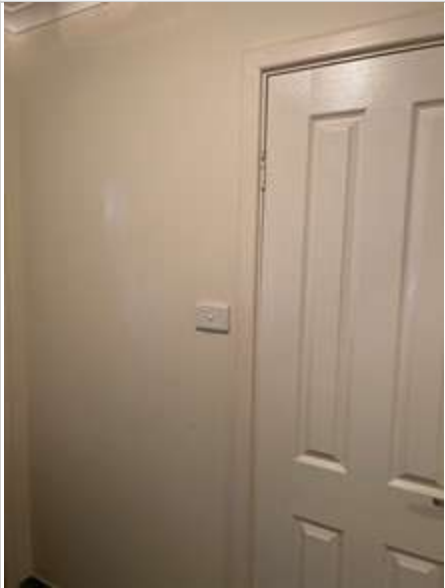
Laundry 02/05/2023 2:01 PM Image 388 :Walls/ Tiles
