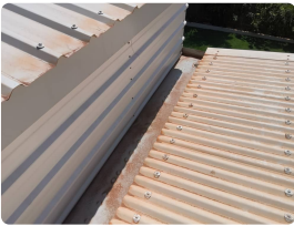
Item: Box gutters
